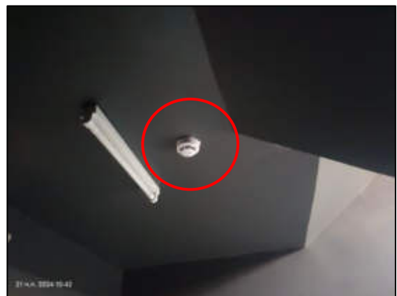
รูปที่ 2-22 เครื่องตรวจจับควัน (Smoke Detector)
