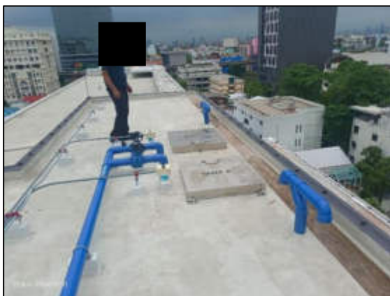
รูปที่ 2-21 ถังสำรองน้ำใช้ชั้นดาดฟ้า
