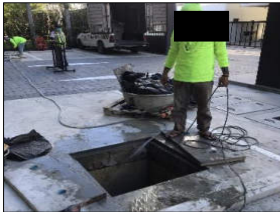
รูปที่ 2-37 กิจกรรมขุดลอกตะกอนที่ระบายน้ำของโครงการ
