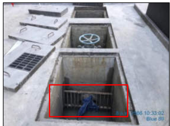
รูปที่ 2-28 ตะแกรงดักขยะบ่อพักน้ำ
